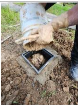
Proceso de terminación con tierra especial para bajar la resistividad del terreno.
