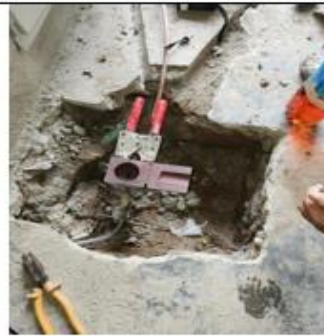
Se realizó excavación e instalación de varillas de cobre y cajas de inspección.
