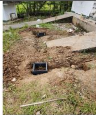
Se realizó excavación e instalación de varillas de cobre y cajas de inspección.
