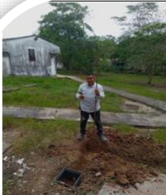
Se realizó excavación e instalación de varillas de cobre y cajas de inspección.
