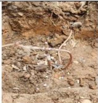
Se realizó excavación e instalación de varillas de cobre y cajas de inspección.
