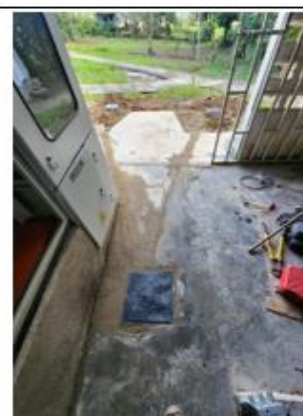
Proceso de terminación con tierra especial para bajar la resistividad del terreno.
