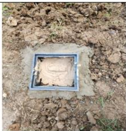
Proceso de terminación con tierra especial para bajar la resistividad del terreno.
