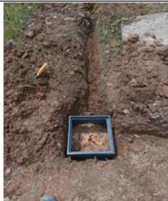
Se realizó excavación e instalación de varillas de cobre y cajas de inspección.
